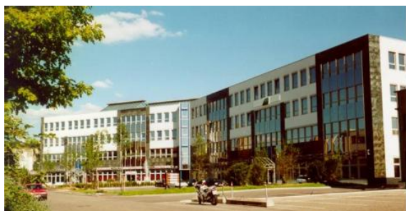
Die Zentrale von SY Technologies im oberpfälzischen Regensburg. Das Projekt SAP LogPro harmonisierte die Prozesse aller sechs Logistikzentren .
